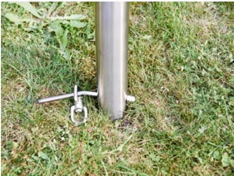
Setzen Sie nun die gebogene Gewindestange am oberen Ende ein und schieben Sie den Drehwirbel darüber. Schrauben Sie die Stange vorerst nur mit der Hand fest.
